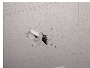
更衣室の天井
