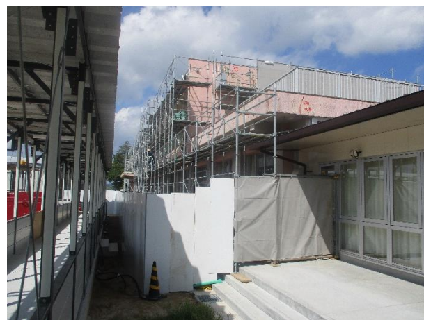
前館工事の様子
