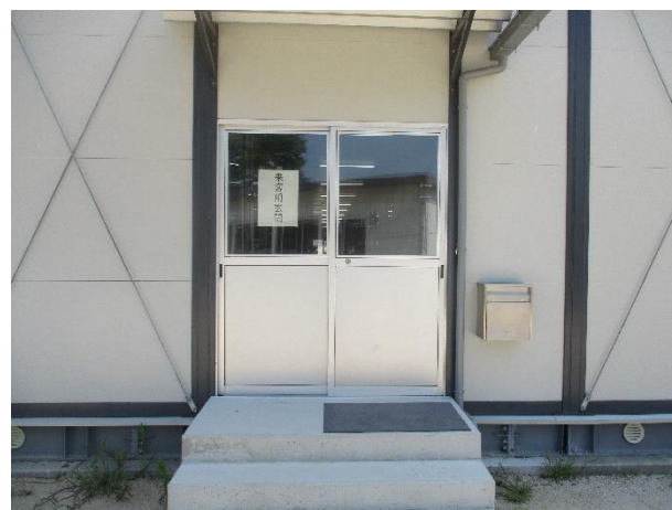
仮玄関（仮校舎西側入口）
