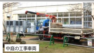
中庭の工事車両
